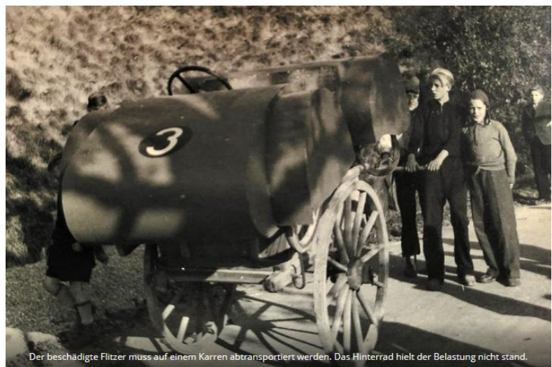
Der beschädigte Fitzer muss auf einem Karren abtransportiert werden. Das Hinterrad hielt der Belastung nicht stand.
